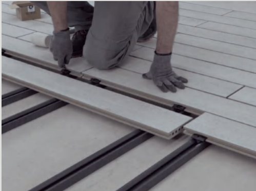
Se termina de fijar con la ayuda de la herramienta C-TOOL. Fixing the boards to the clip with the C-TOOL. On termine de fixer à l'aide de l'outil C-TOOL. Корректировка с помощью инструмента C-TOOL.
