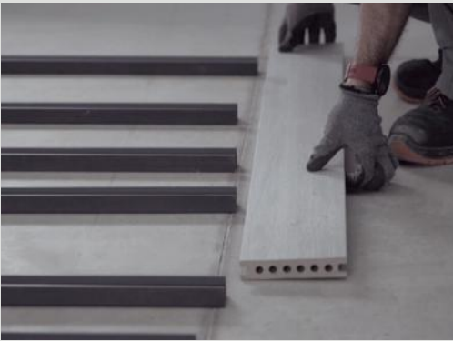
Usar una lama como referencia. Use a board as a reference Utiliser une lame comme référence. Используйте планку в качестве ориентира.
