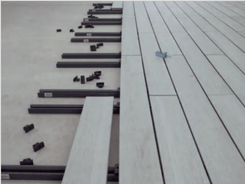
Se continua con la instalación del resto de lamas. Continuing to lay the rest of the boards. On continue avec l'installation du reste des lames. Установка последующих планок.
