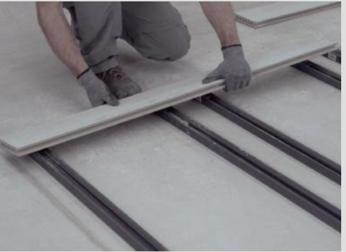
Instalación primera hilera de lamas. Fitting the first row of boards. Installation première rangée de lames. Установка первого ряда ламелей.
