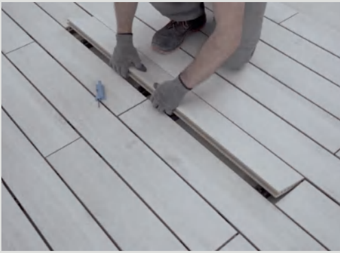
Para retirar las lamas registrables se debe utilizar la herramienta C-TOOL. Use the C-TOOL to lift up the removable boards. Pour retirer les lames amovibles on doit utiliser l'outil C-TOOL. Для снятия ламелей необходимо использовать инструмент C-TOOL.
