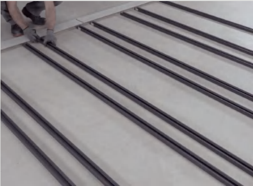
Cada lama debe estar apoyada sobre 4 rastreles como mínimo. Each board must be supported by at least four battens. Chaque lame doit être appuyée sur 4 traverses au minimum. Каждая планка должна поддерживаться как минимум на 4 дорожках.
