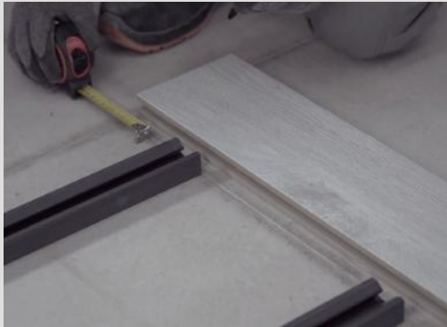
Respetar las distancias recomendadas de colocación. Always comply with recommended installation distances. Respecter les distances de pose recommandées. Соблюдайте рекомендуемые расстояния размещения.
