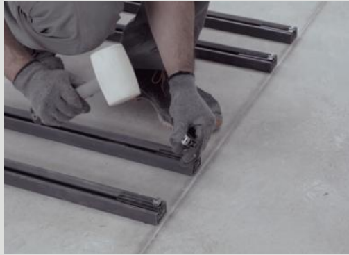
3 COLOCACIÓN DE LA GRAPA/CLIP TERMINAL MEDIANTE PRESIÓN. CLICKING IN THE END CLIP. POSE DE L'AGRAFE/CLIP TERMINAL PAR PRESSION. РАЗМЕЩЕНИЕ КЛЕММНОЙ СКОБЫ/ЗАЖИМА ПОД ДАВЛЕНИЕМ.
