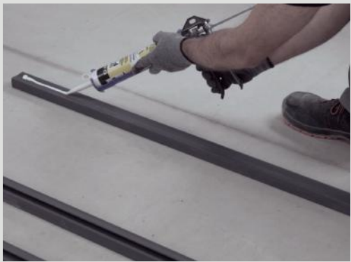
Se puede utilizar anclaje químico cuando no sea posible utilizar el mecánico. A chemical bonding system can be used when a mechanical fixing system is not possible. On peut utiliser un ancrage chimique quand il n'est pas possible d'utiliser l'ancrage mécanique. Химическая анкеровка может быть использована, когда невозможно использовать механическую.
