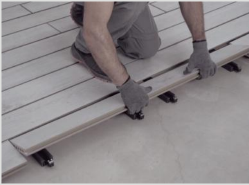
6 COLOCACIÓN DE LA ÚLTIMA HILERA DE LAMAS con clips terminales. LAYING THE LAST ROW OF BOARDS with end clips. POSE DE LA DERNIÈRE RANGÉE DE LAMES avec des clips terminaux. РАЗМЕЩЕНИЕ ПОСЛЕДНЕГО РЯДА ЛАМЕЛЕЙ с финальными клямерами.
