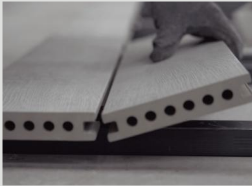
Colocación de las siguientes lamas con el mismo sistema. Laying the following boards in the same way. Pose des lames suivantes avec le même système. Размещение следующих ламелей с одинаковым шагом.
