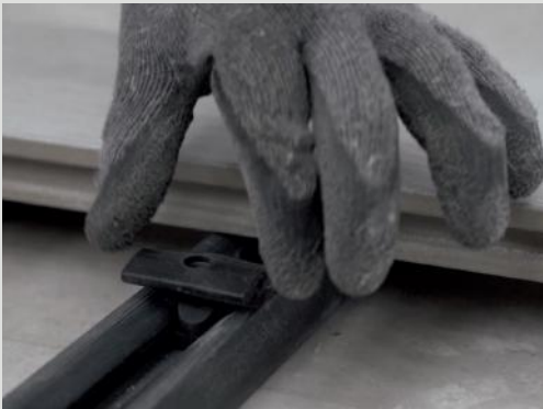
4 COLOCACIÓN DE LA GRAPA FIJA INTERMEDIA MEDIANTE PRESIÓN. CLICKING IN THE QUICK FIX INTERMEDIATE CLIP. POSE DE L'AGRAFE FIXE INTERMÉDIAIRE PAR PRESSION. РАЗМЕЩЕНИЕ ПРОМЕЖУТОЧНОГО НЕПОДВИЖНОГО КЛЯМЕРА.
